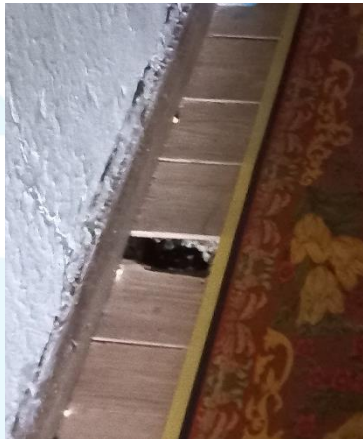
Figura 1 - Pavimento degradado
